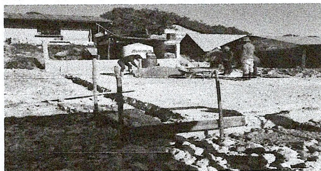
Foto 2: El Albañil juntamente con los consejo de padre de familia se encuentra midiendo el lugar de la Escuela.
