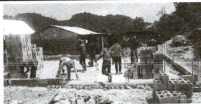
Foto 6: El Albañil y padres de familias se encuentran colocando los bloks.
